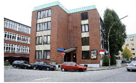
Das Gebäude an der Ecke Eschelsweg/ Mörkenstraße steht leer und wird derzeit von Maklern zur Vermietung angeboten.
