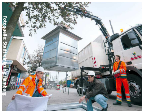
Die Installation eines Unterflursystems
